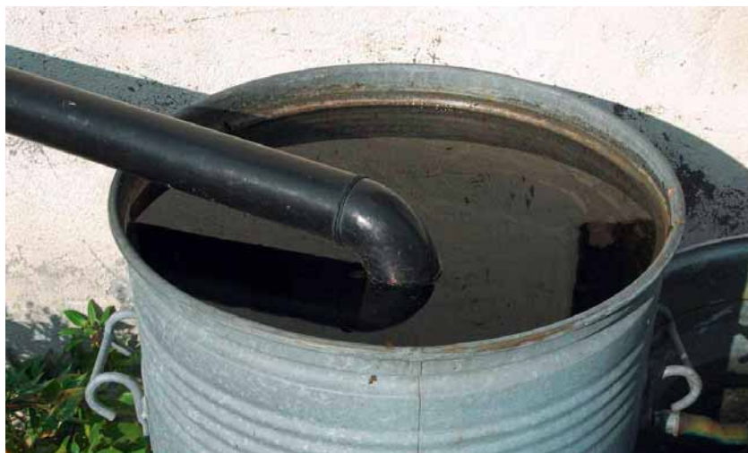
Auf simple Weise im Fass gesammeltes Regenwasser, kann nach Bedarf mit der Spritzkanne geschöpft und genutzt werden.
