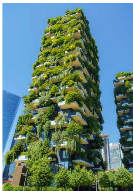
von links: Begrünung mittels an Fassade montierten Gefässen (Visualisierung). Gebäude mit Kletterpflanzen, durch Haftwurzeln selbsthaftend oder mittels Drahtseilen oder Gittern als Rankhilfen. «Bosco Verticale» in Mailand: mit Trögen an der Gebäudehülle
